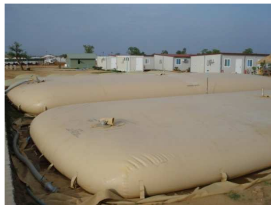
น้ำที่นำมาจากบ่อน้ำบาดาลจะนำมาเก็บไว้ในถุง
