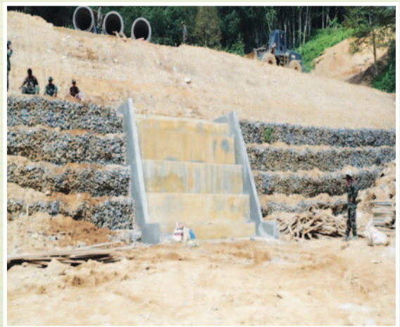
ภาพการก่อสร้าง Stepped drain chute
