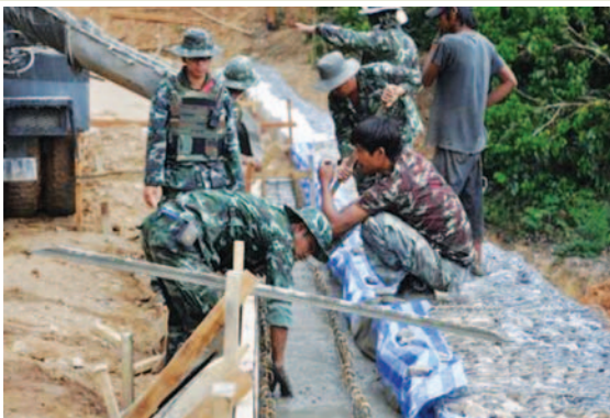
ภาพการก่อสร้าง interceptor
