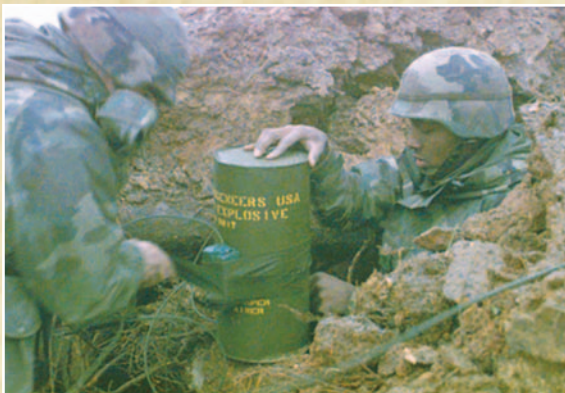
ทหารช่างสนามสหรัฐฯ กำลังใช้ระเบิดแบบ shape charges ขนาด ๔๐ปอนด์ ทำลายบังเกอร์ของ ทหารเชิร์บในบอสเนียเฮอร์เซโกวีนา (พ.ศ.๒๕๕๕)
