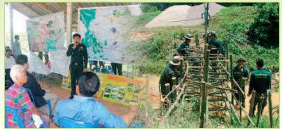
พล.ต.ชาญวุฒิ อินทุภักชฌ์ ผบ.พล.พัฒนา ๔ เข้าร่วมประชุมเสวนากับประชาชนในพื้นที่ และร่วมกันสร้างฝายกั้นน้ำบริเวณคลองจำไทร บ้านทุ่งไชน ต.โคกม่วง อ.คลองหอยโข่ง จ.สงขลา เมื่อ ๒๙ เม.ย. ๕๓
