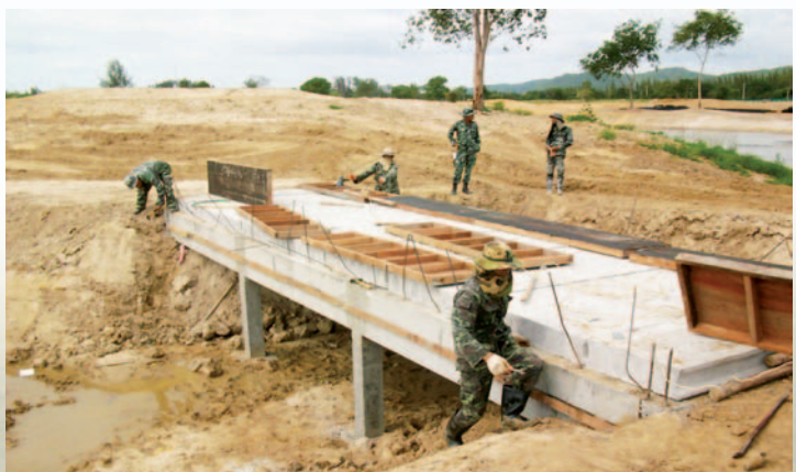
งานก่อสร้างสะพานบริเวณหลุม ๑๓
