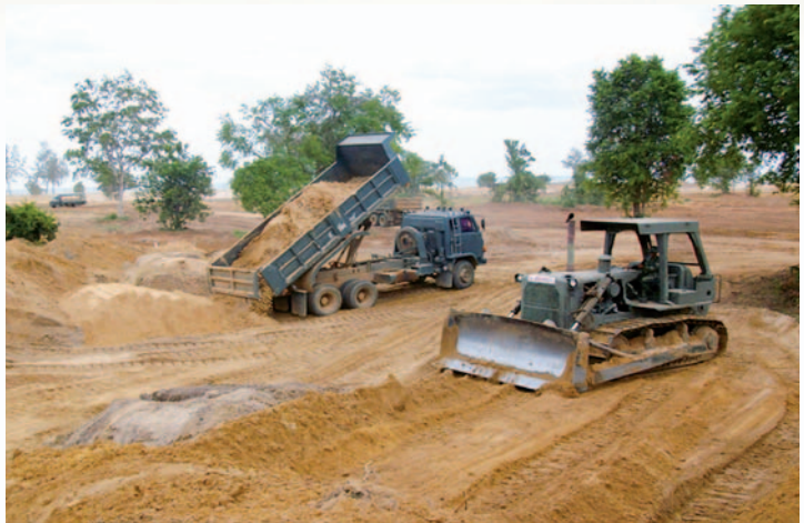
งานขนย้ายที่ดินบริเวณพื้นที่ก่อสร้างภายในสนามกอล์ฟ
